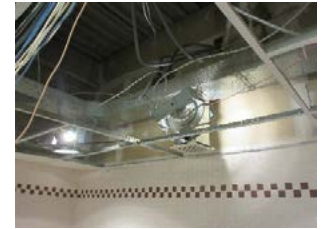
Photo 4.9 Toilet Exhaust Fan
